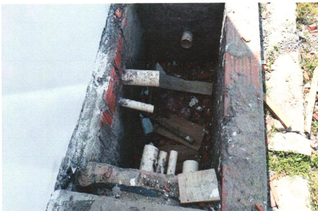
Foto 12 - Sumidouro paredes com blocos cerâmicos 6 furos e dimensões internas de 1,75 x 1,00 x 1,00 m
