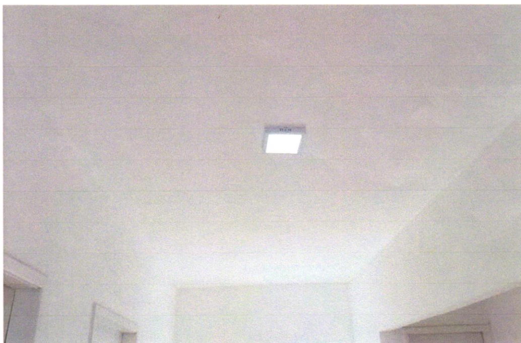
FOTO 01 – Forro de gesso comum, em placas 60x60 cm, inclusive madeiramento com ripões 3,5cm x 5,5cm, instalado
