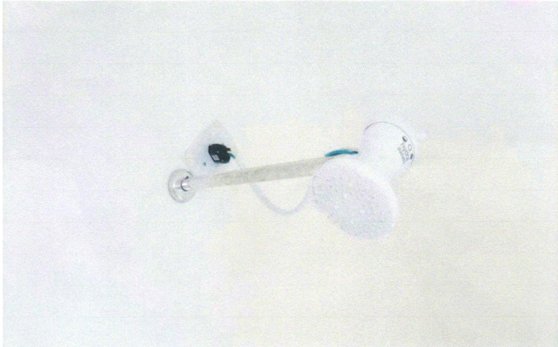
Foto 09 - CHUVEIRO ELÉTRICO COMUM CORPO PLÁSTICO, TIPO DUCHA ☑ FORNECIMENTO E INSTALAÇÃO. AF_01/2020
