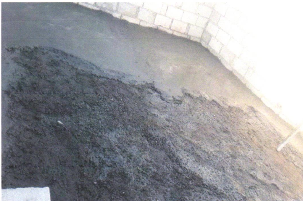
Foto 07 - Concreto simples fabricado na obra, fck=25 mpa, lançado e adensado
